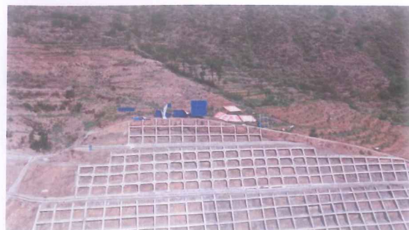
互通框格梁护坡
