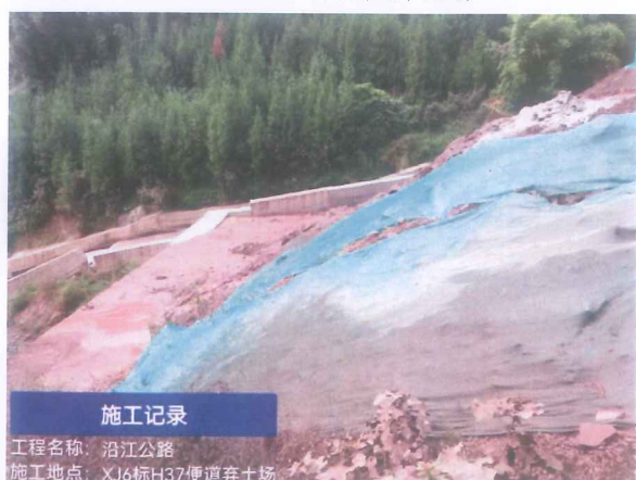
H37 便道 2#弃渣场
