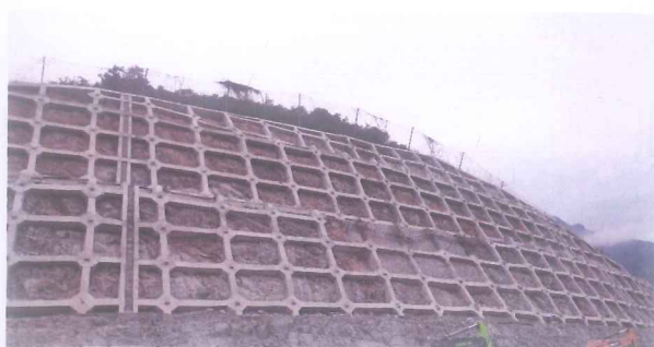
桥梁框格梁护坡
