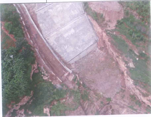
弃渣场挡墙及削坡防护
