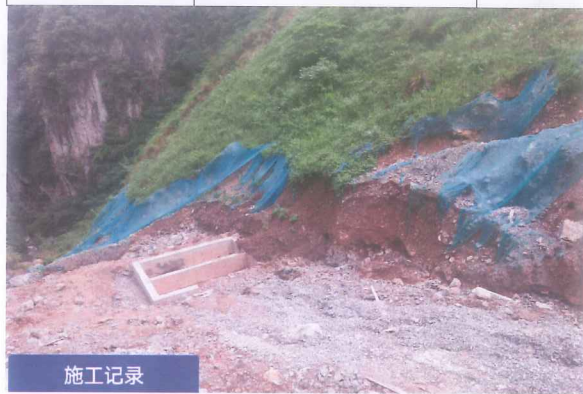
弃渣场沉砂池
