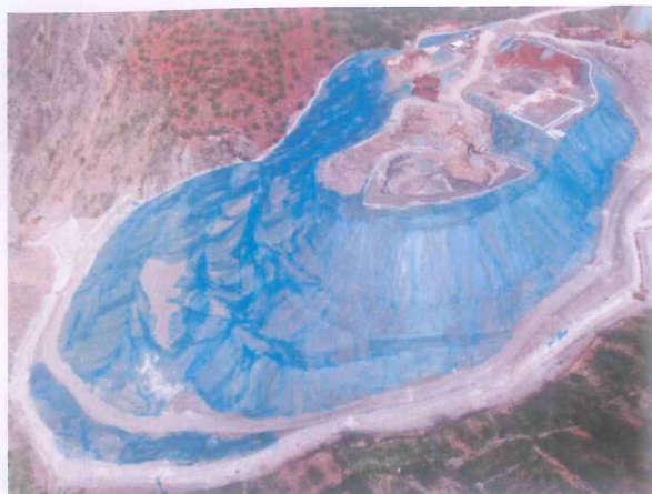
弃渣场挡墙施工
