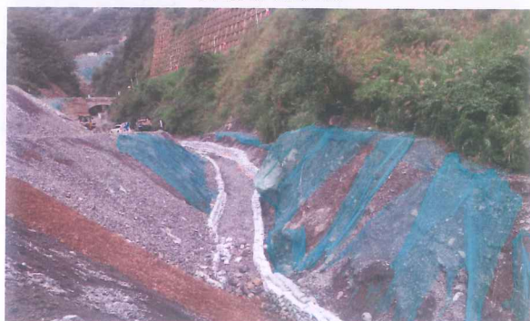
弃渣场临时装土草袋
