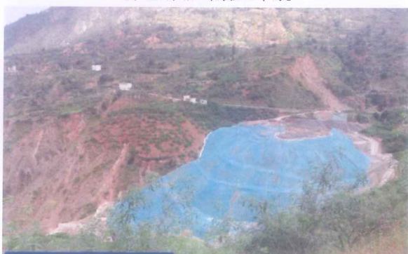
弃渣场临时苫盖
