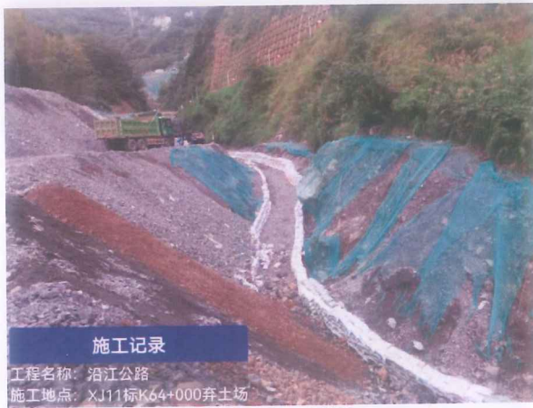
K64+000 西边沟#弃渣场
