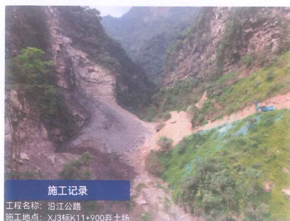
K11+900 大河沟#弃渣场
