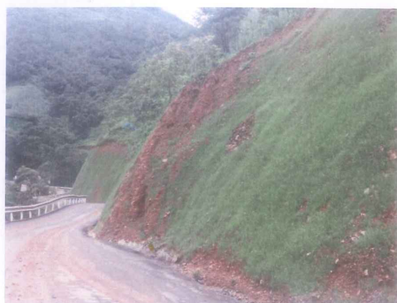
便道边坡播撒草籽
