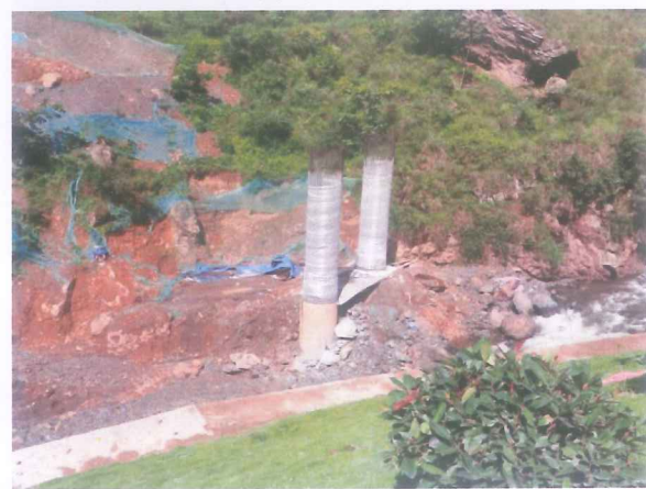
桥梁工程施工
