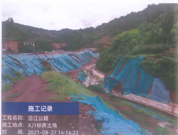
K1+168 兵茅坝支沟#弃渣场
