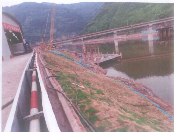
拌合站边坡植草
