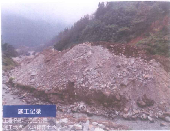
K39+000 火烧棚沟支沟弃渣场
