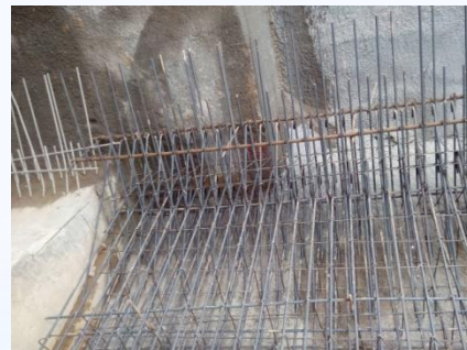
仰拱和二衬钢筋精度
