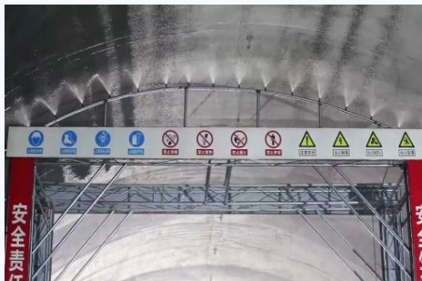
隧道二衬砼自动喷淋
