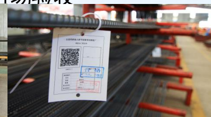
钢筋加工工序验收
