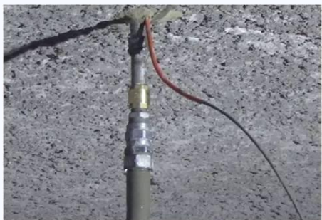
隧道拱顶锚杆注浆
