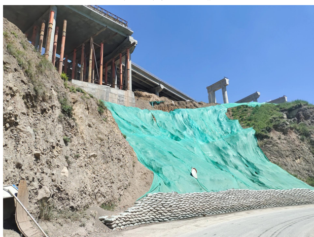
施工便道临时拦挡及苫盖
