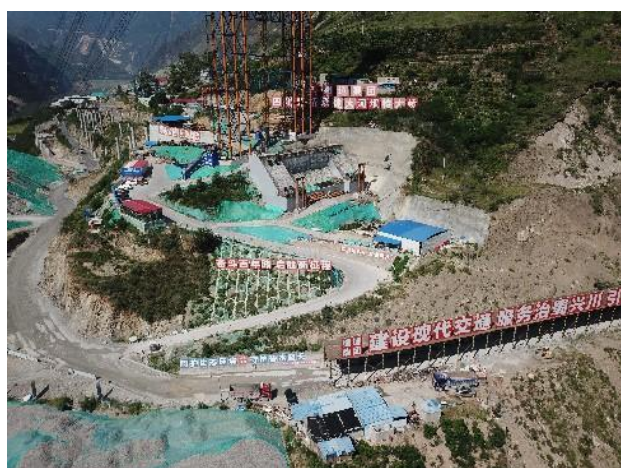
桥梁框格梁护坡
