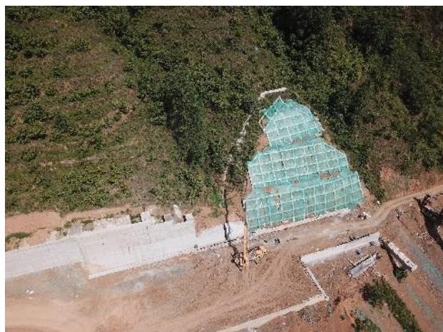
桥梁框格梁护坡
