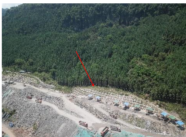
互通框格梁护坡
