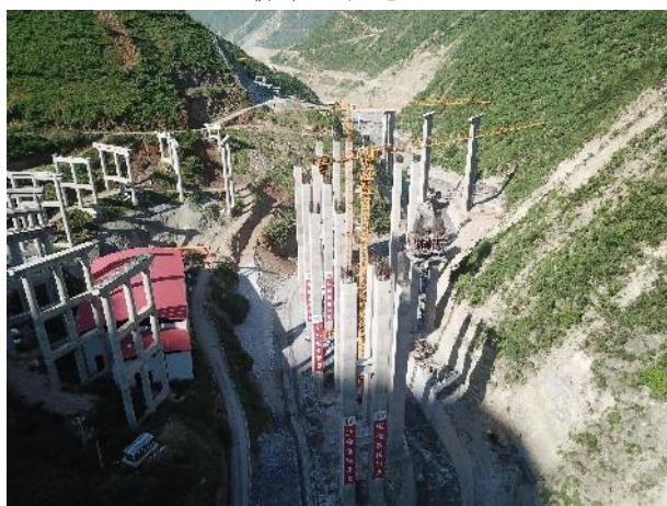
桥梁工程施工
