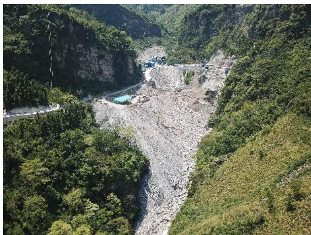
K14+570 梯子岩沟#弃渣场
