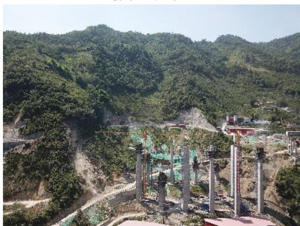
互通工程施工
