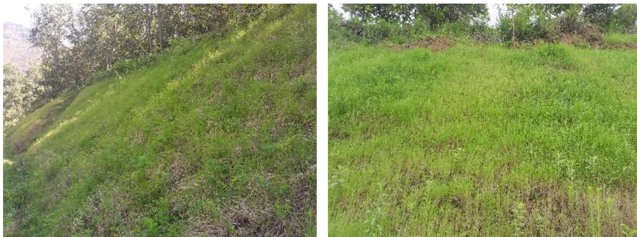
施工便道边坡喷播植草
