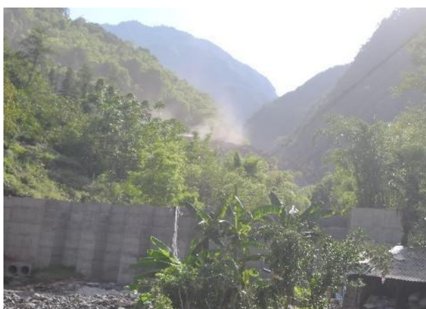
弃渣场混凝土挡墙
