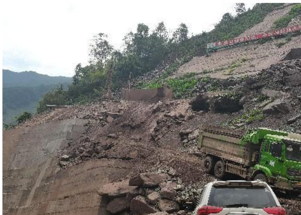
施工便道混凝土挡墙
