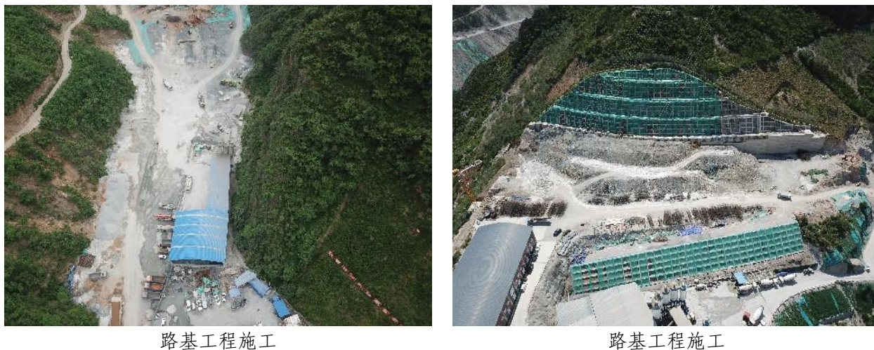
图 1-2 本季度工程建设情况
