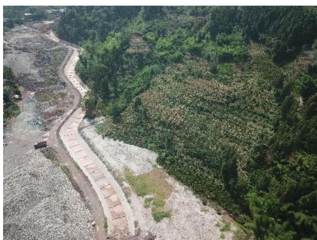
K1+168 兵茅坝支沟#弃渣场
