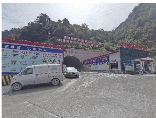
隧道工程施工
