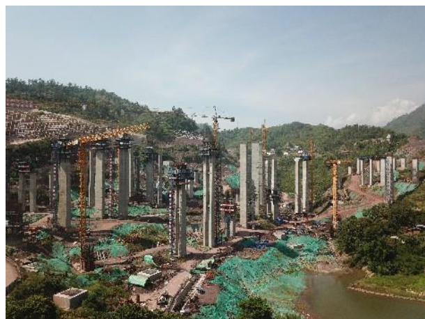
互通工程施工
