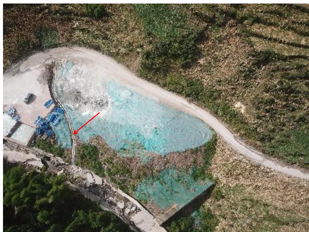
弃渣场临时苫盖及排水
