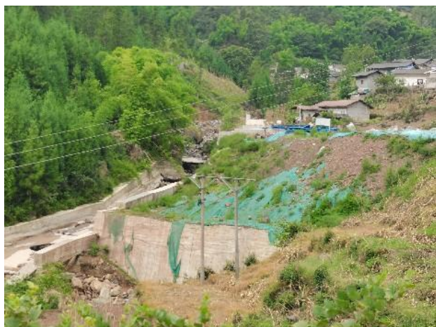
H37 便道 2#弃渣场
