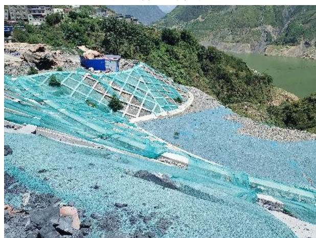
隧道边坡临时苫盖
