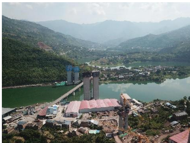
桥梁工程施工
