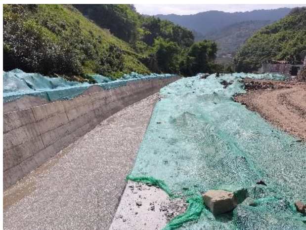
K34+000 柑子坪沟#弃渣场
