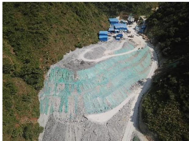
K72+100 鲁村沟#弃渣场
