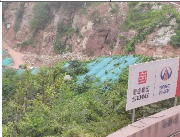
桥梁临时苫盖
