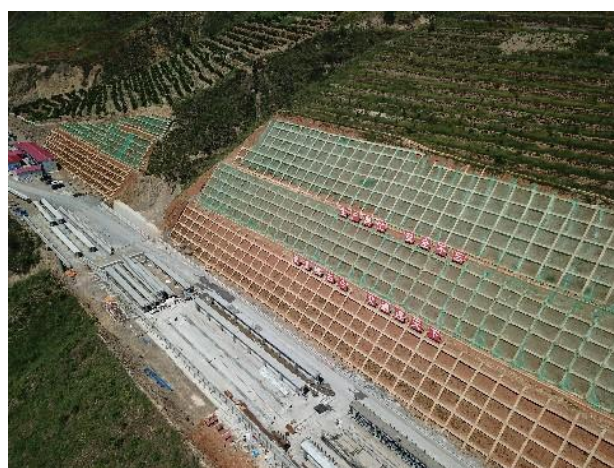
预制梁场边坡防护
