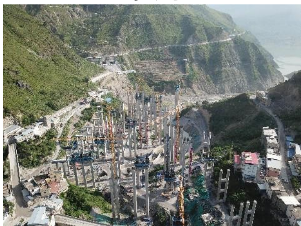
互通工程施工
