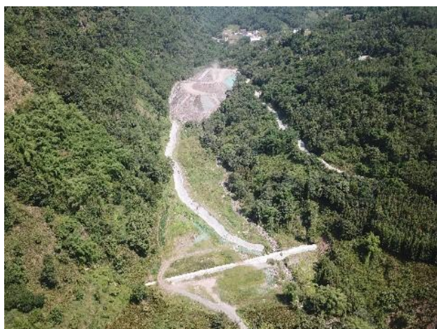
弃渣场临时排水
