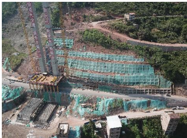
桥梁框格梁护坡
