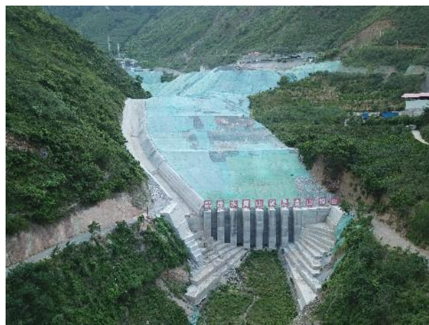
反压体泄洪沟及挡墙
