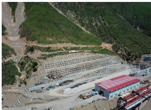
互通框格梁护坡
