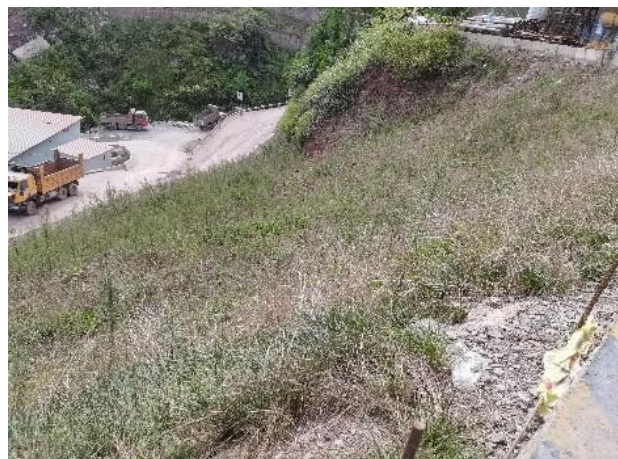
隧道出口播撒草籽
