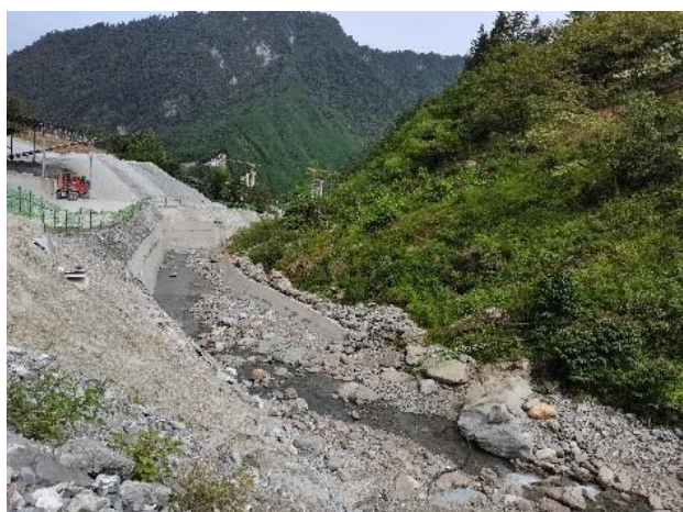
K39+000 火烧棚沟支沟#弃渣场
