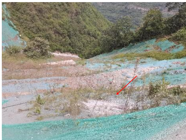
桥梁临时苫盖
