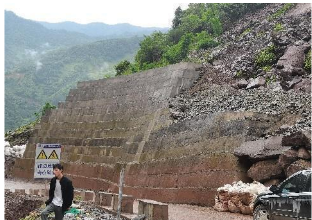
施工便道混凝土挡墙
