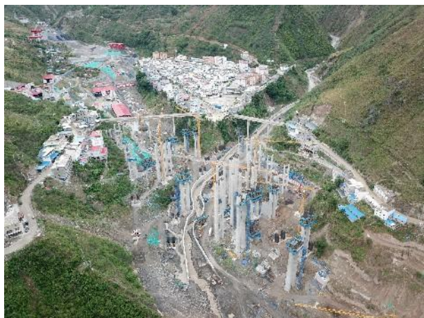
互通工程施工
