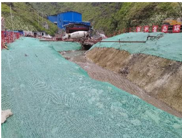
隧道边坡临时苫盖
