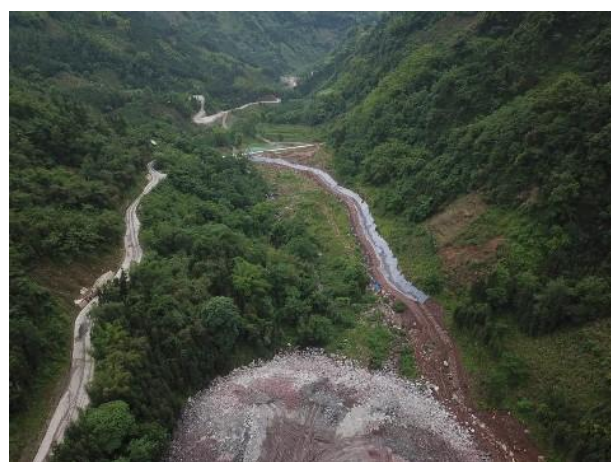
弃渣场临时排水
