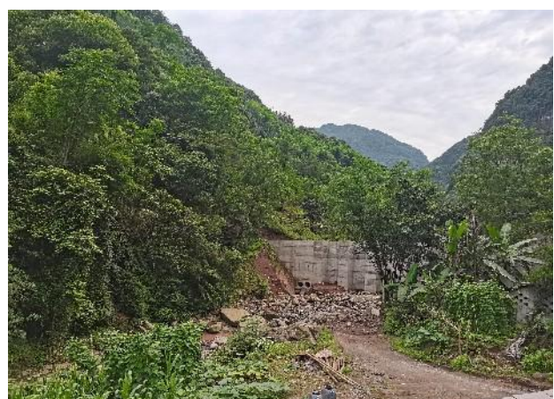
弃渣场混凝土挡墙
