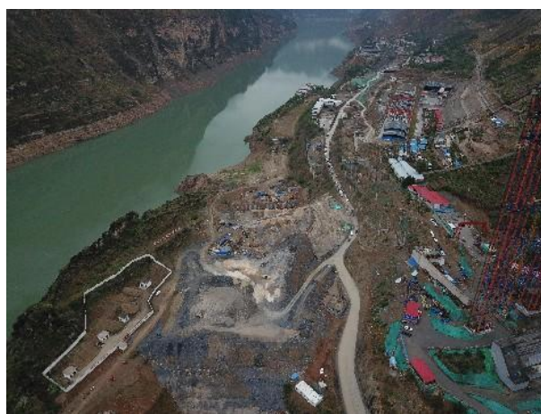
路基工程施工
