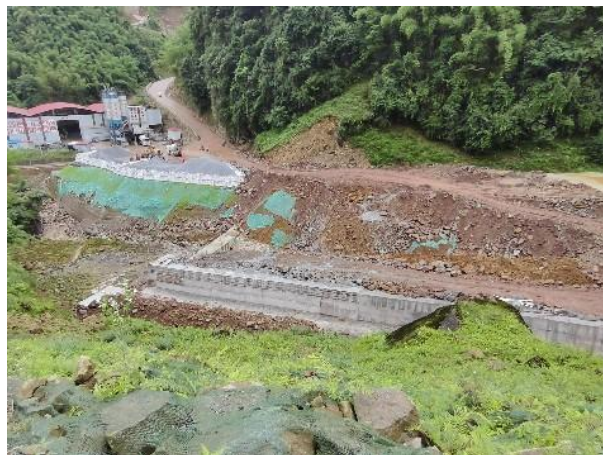
K34+000 柑子坪沟#弃渣场
