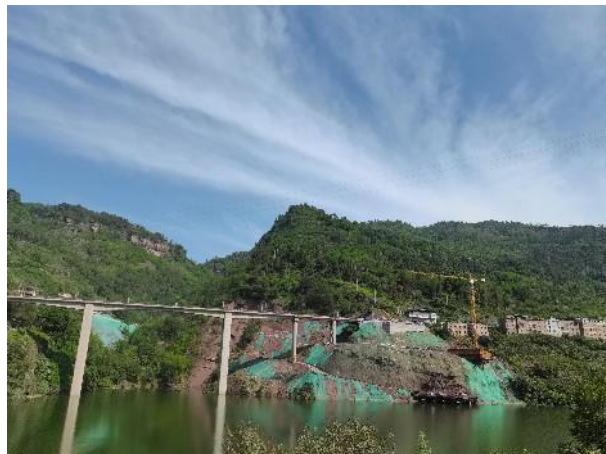
桥梁临时苫盖
