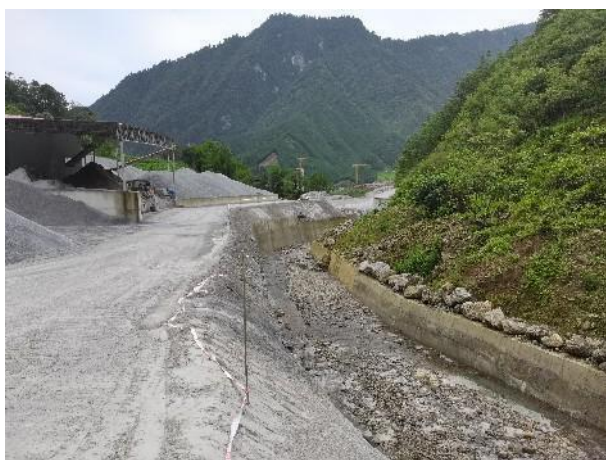
K39+000 火烧棚沟支沟#弃渣场
