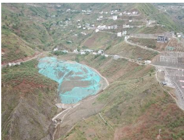
弃渣场临时苫盖
