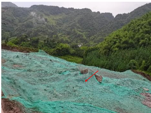
弃渣场临时苫盖
