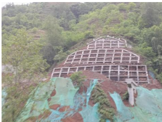
桥梁框格梁护坡
