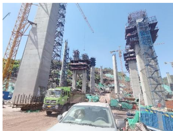
互通工程施工
