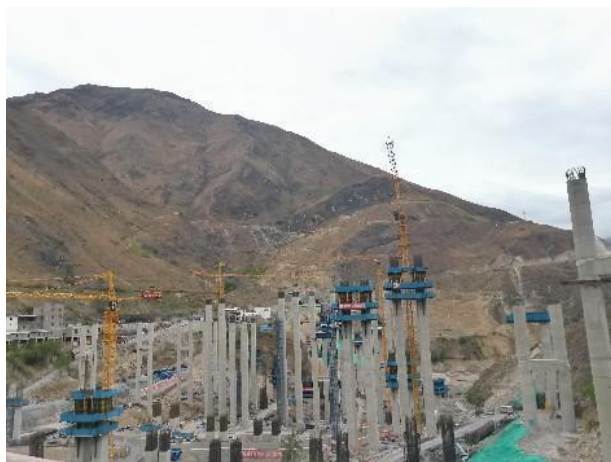
互通工程施工
