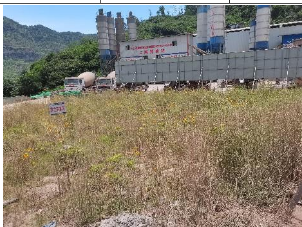
拌合站播撒草籽
