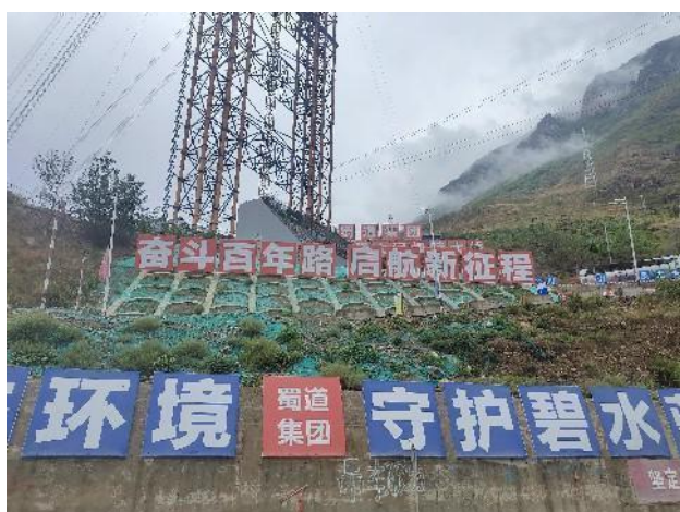
桥梁框格梁护坡
