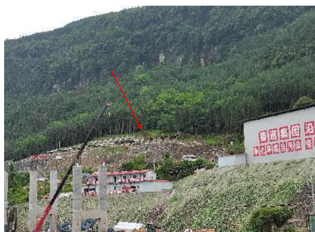
互通框格梁护坡
