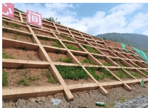
互通框格梁护坡
