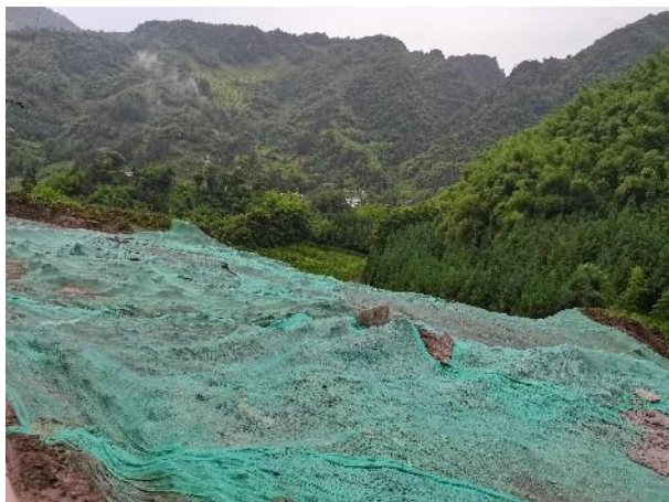
H37 便道 2#弃渣场
