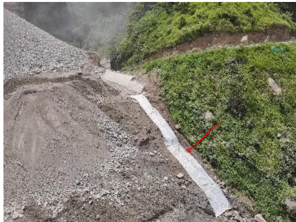
弃渣场临时排水
