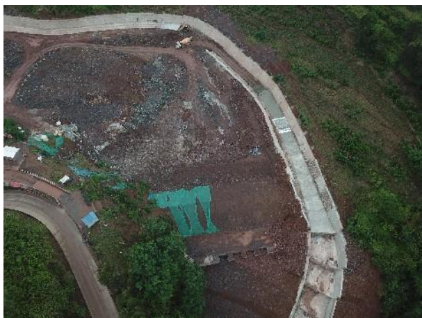
K1+168 兵茅坝支沟#弃渣场
