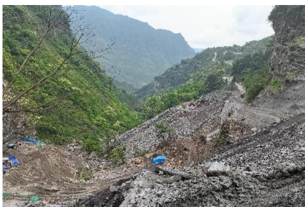
K14+570 梯子岩沟#弃渣场
