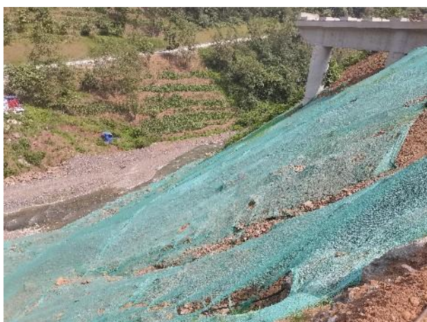
桥梁边坡临时苫盖
