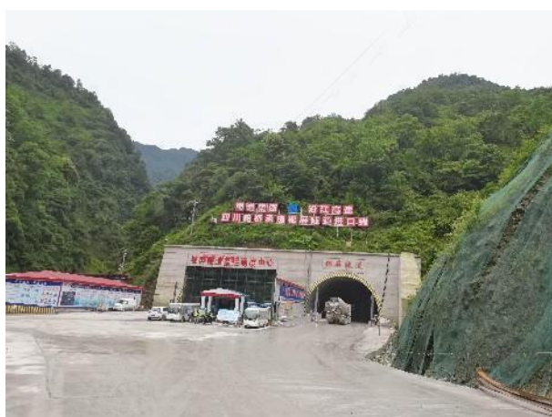
隧道工程施工
