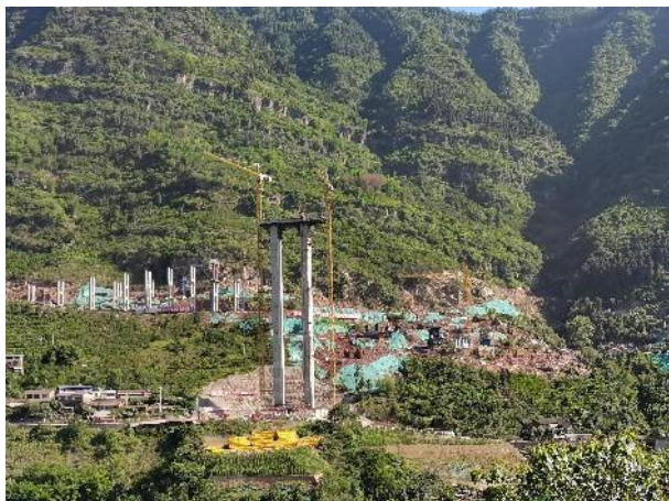
桥梁工程施工
