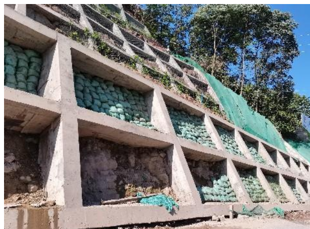
桥梁框格梁护坡
