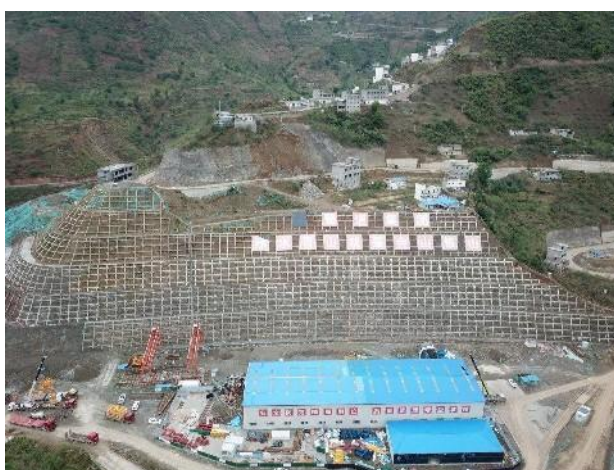
桥墩边坡防护
