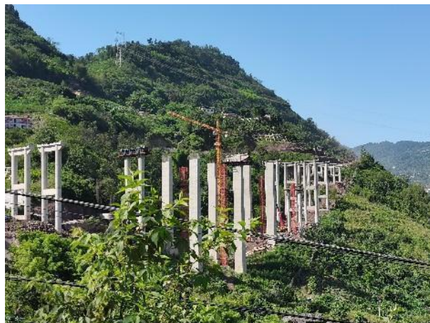
桥梁工程施工
