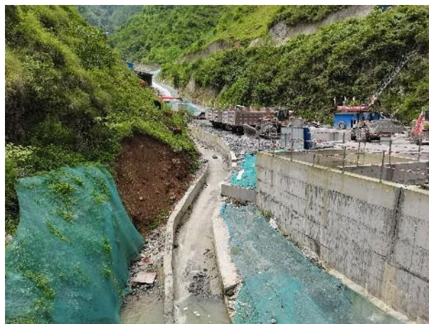
K72+100 鲁村沟#弃渣场
