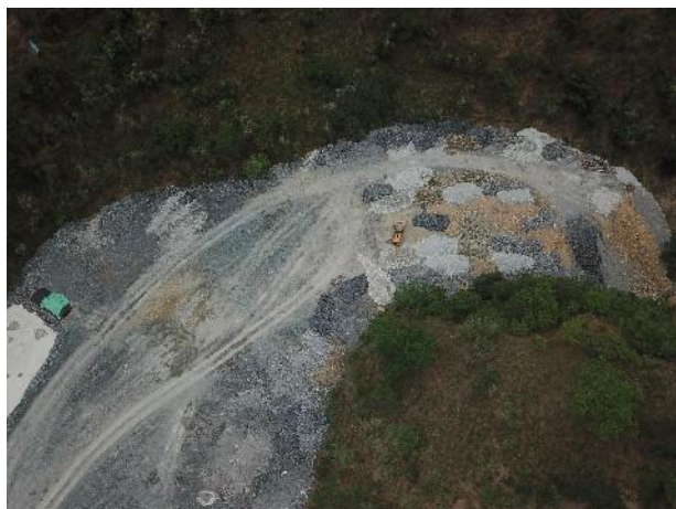
路基工程施工
