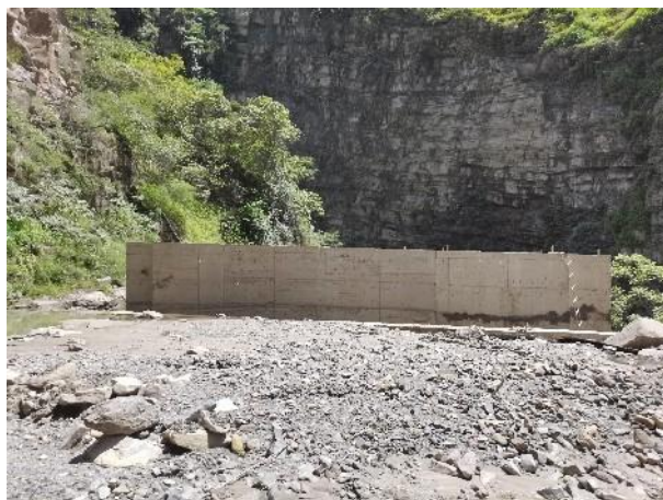
K11+900 大河沟#弃渣场
