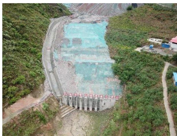
反压体泄洪沟及挡墙
