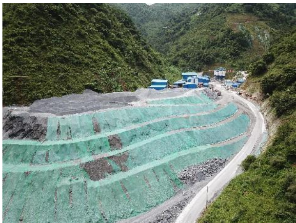
K72+100 鲁村沟#弃渣场
