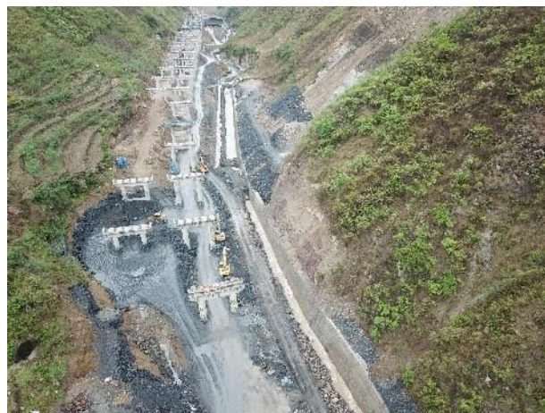
桥梁工程施工
