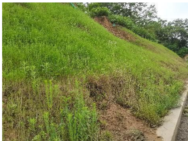
施工便道边坡喷播植草
