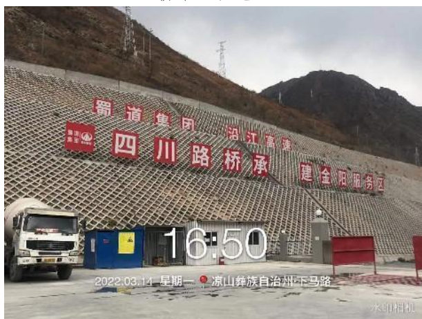
服务区施工施工
