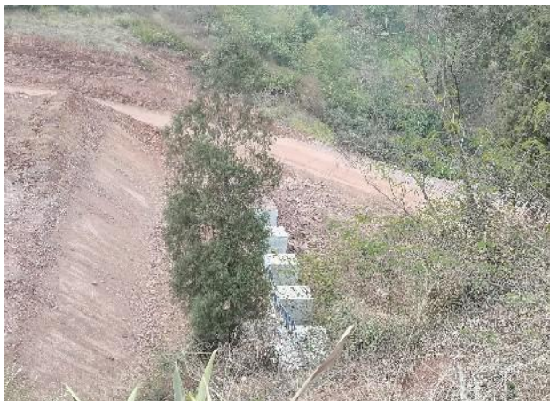
弃渣场挡墙及削坡防护
