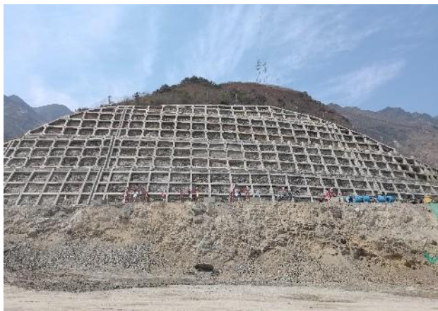
桥梁框格梁护坡
