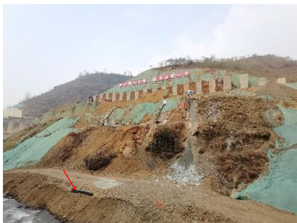
隧道临时装土草袋
