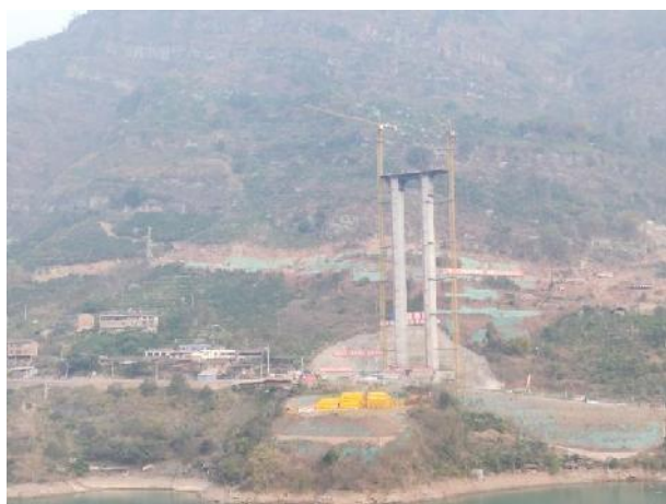
桥梁工程施工
