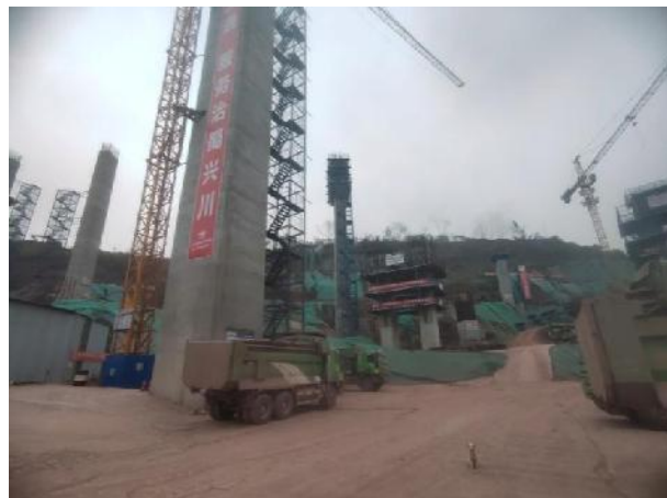
互通工程施工
