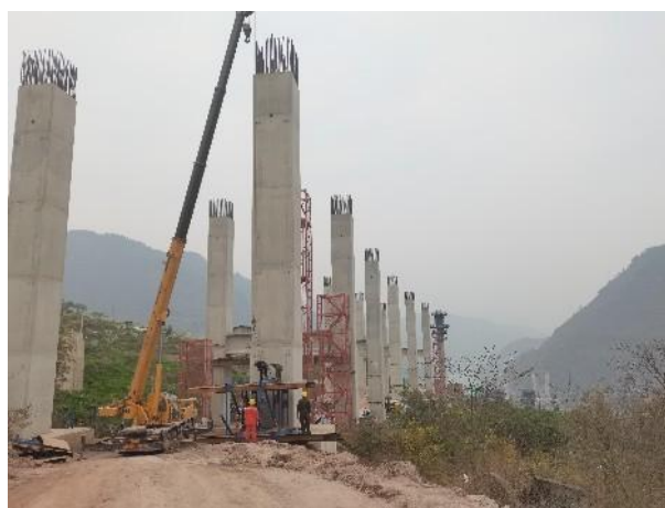
桥梁工程施工
