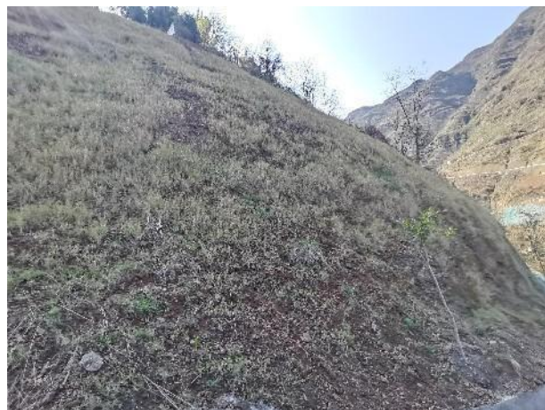
施工便道边坡喷播植草
