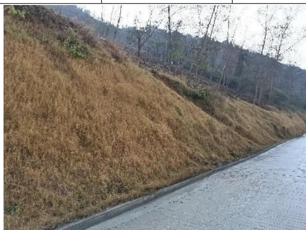
便道边坡播撒草籽
