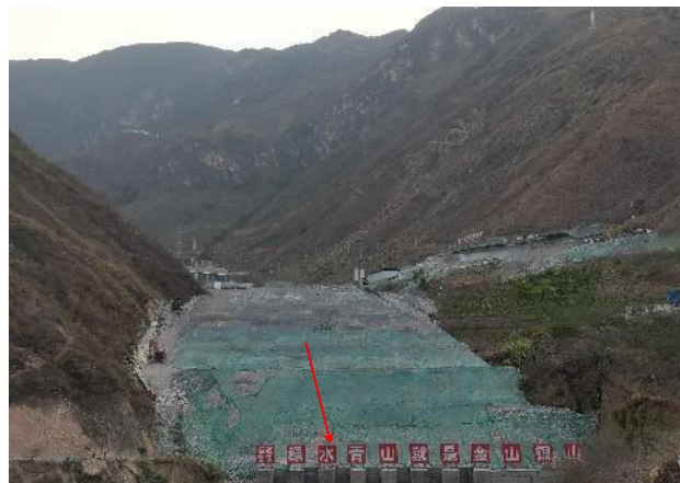
反压体挡墙修建
