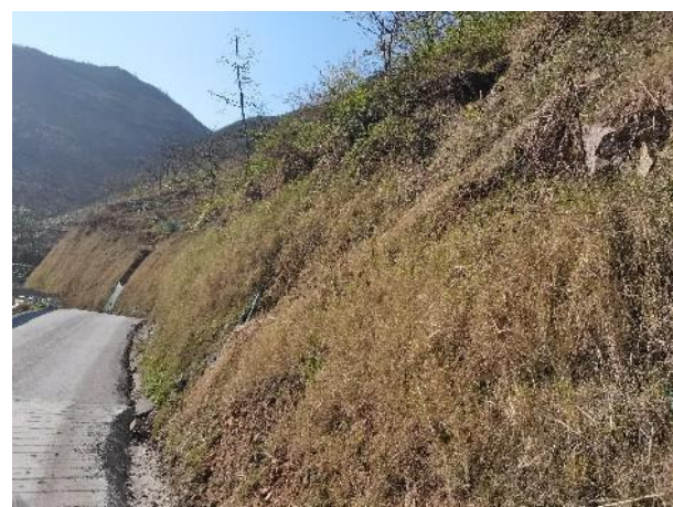
施工便道边坡喷播植草
