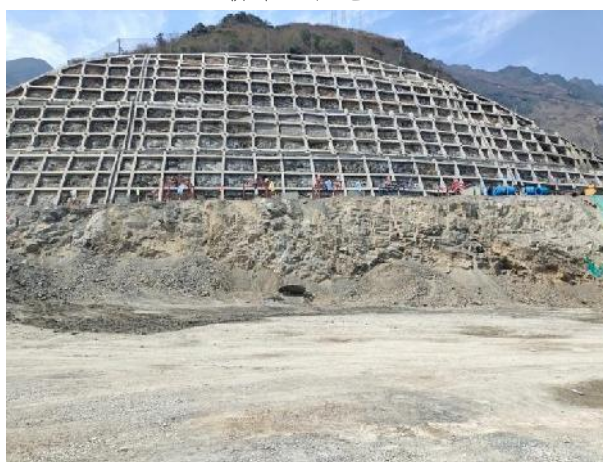
路基工程施工
