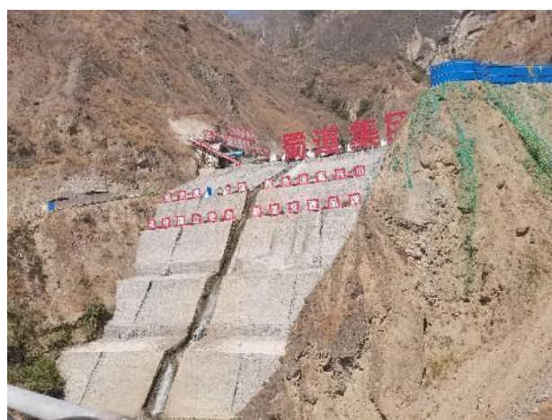
反压体浆砌石护坡
