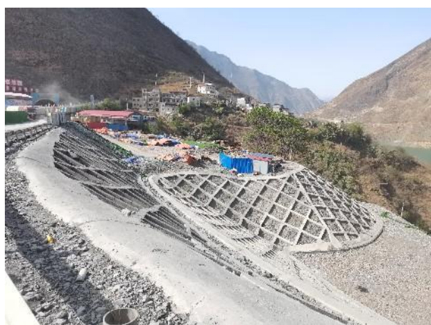
路基框格梁护坡
