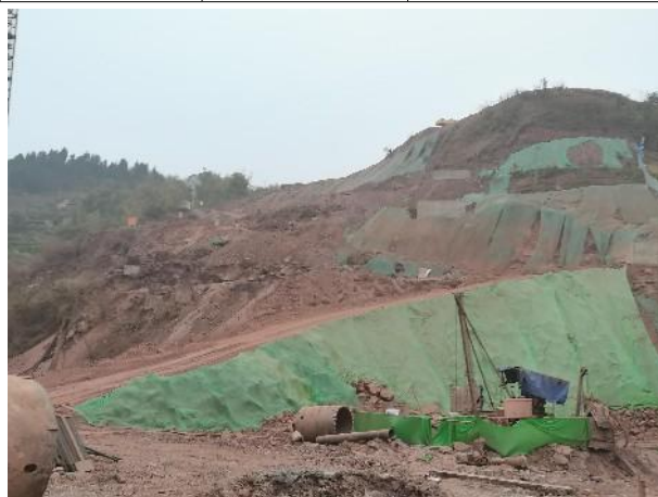
互通临时苫盖
