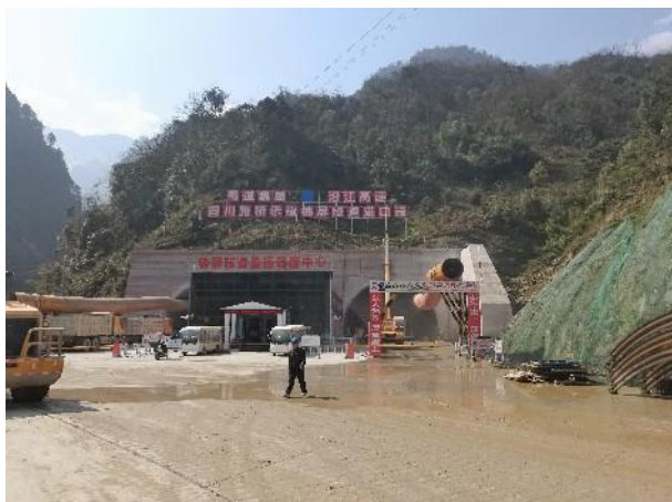
隧道工程施工
