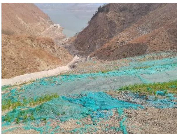
反压体临时苫盖及播撒草籽
