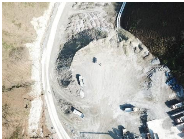
K72+100 鲁村沟弃渣场
