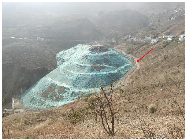
弃渣场临时排水沟
