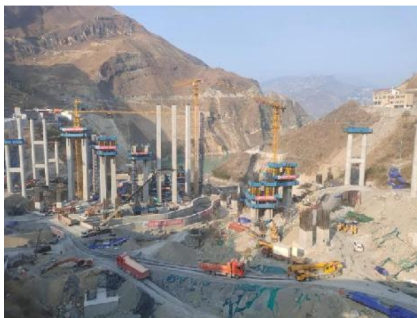
互通工程施工
