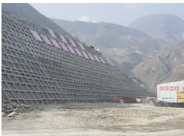
桥梁框格梁护坡
