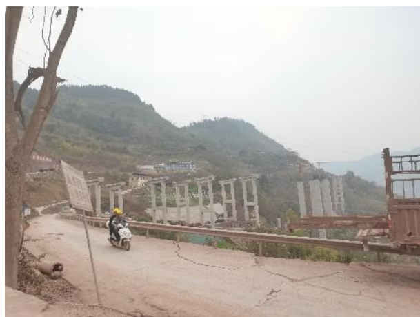
桥梁工程施工
