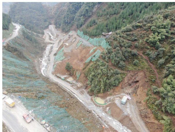
7 标段火烧棚沟特大桥未剥离表土
