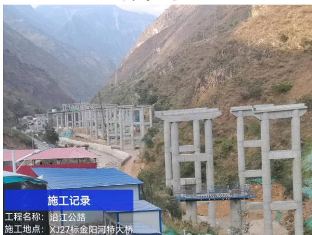
桥梁工程施工
