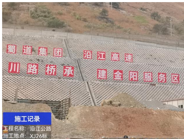
服务区框格梁护坡
