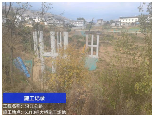
桥梁工程施工
