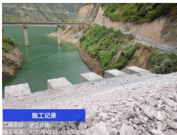
反压体挡墙修建
