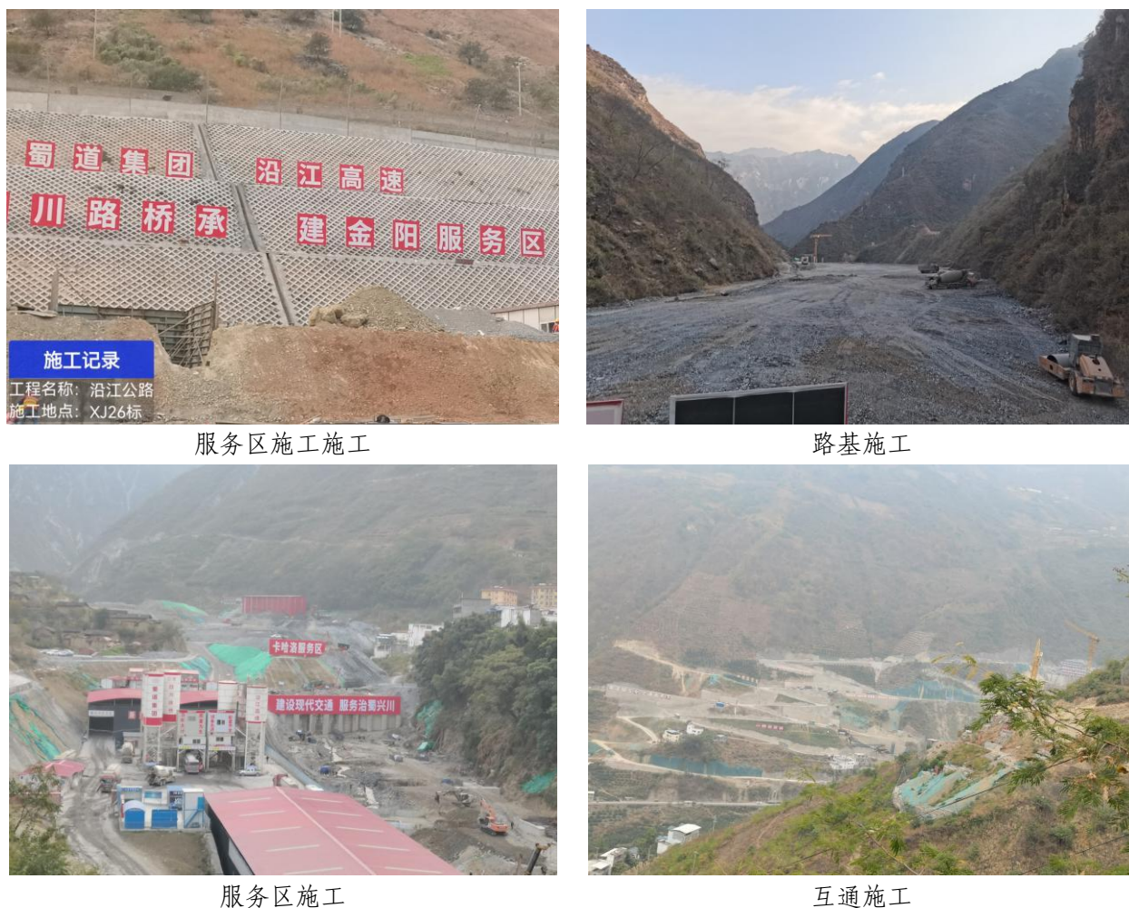
图 1-2 本季度工程建设情况
