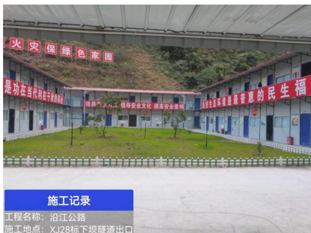
施工营地内景观绿化
