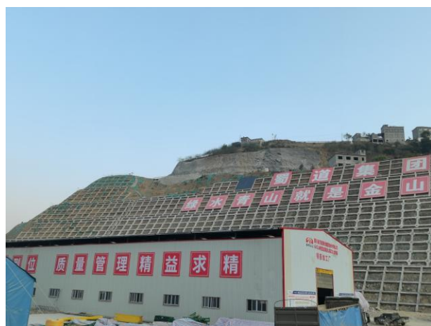
桥梁框格梁护坡
