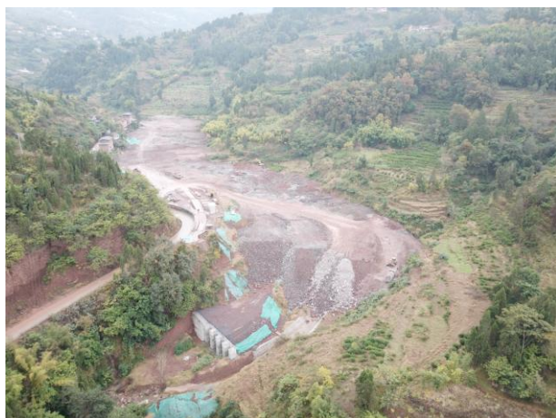
弃渣场挡墙及削坡防护
