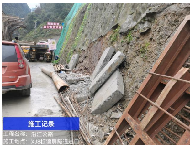
8 标段锦屏隧道进口施工便道内边坡排水沟堵塞
