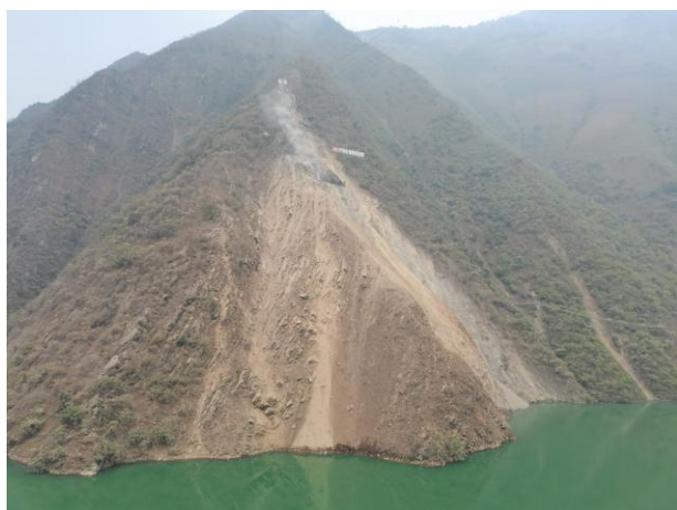
15 标段西苏角河大桥施工场地溜渣入江
