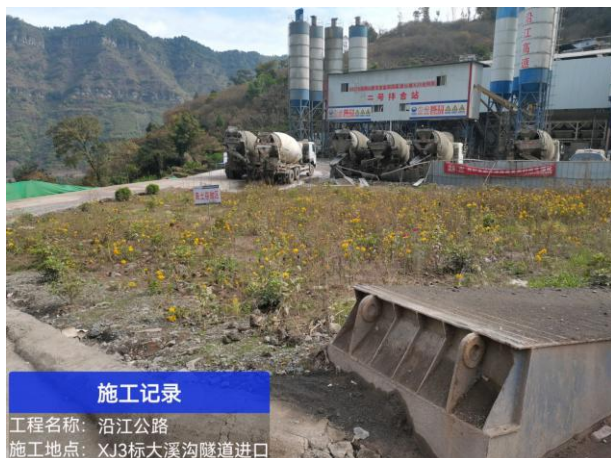
拌合站播撒草籽
