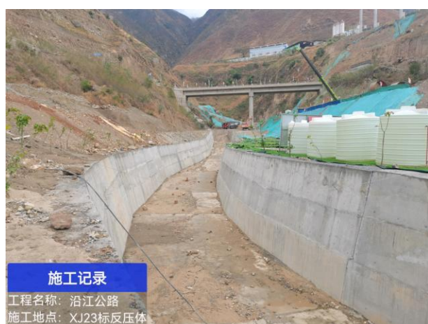
反压体泄洪沟
