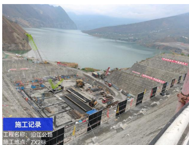
桥梁浆砌石护坡
