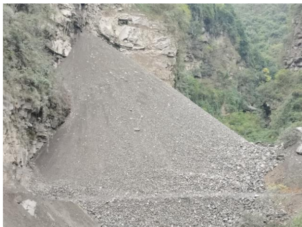
3 标段 K11+900 大河沟弃渣场堆渣坡度太大
