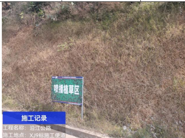
便道边坡播撒草籽
