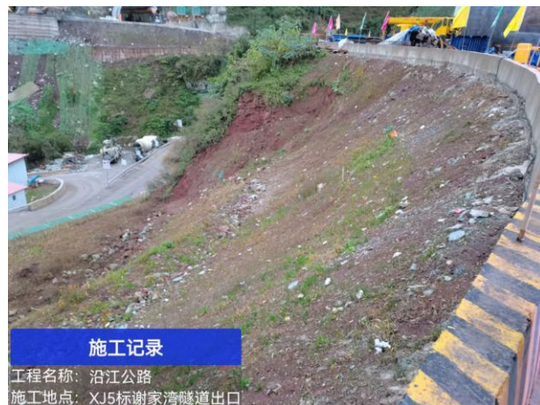
隧道边坡播撒草籽
