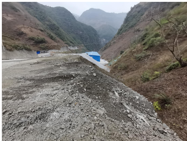
K72+100 鲁村沟弃渣场
