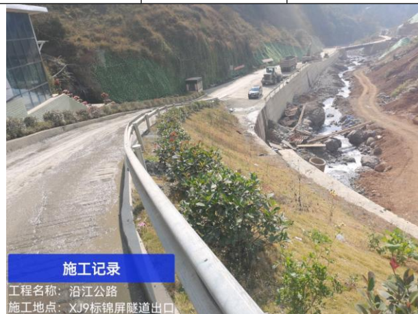
便道边坡播撒草籽
